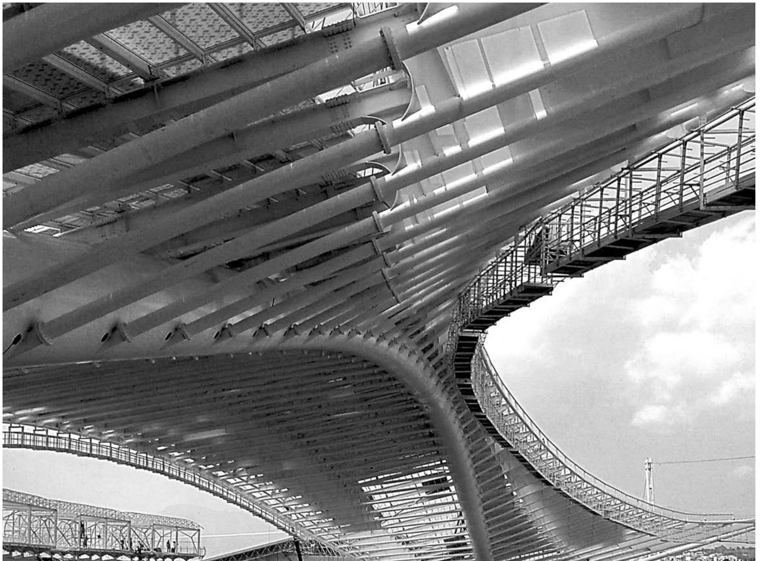
STADIO OLIMPICO DI ATENE. COSTRUZIONI CIMOLAI. FOTO CESARE GENUZIO
