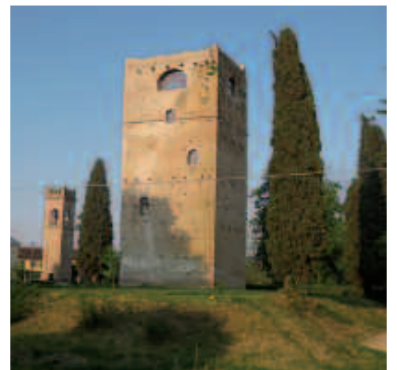
La Torre del Castello Sbrojavacca
