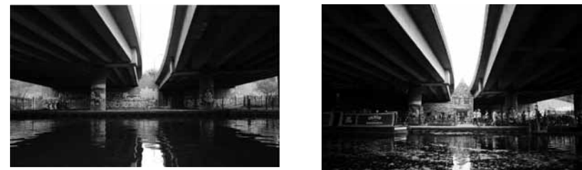
Fig. 4 - Luogo dell'installazione Folly for a Flyover prima (sinistra) e dopo la realizzazione. [Fonte: http://www.pavillon-arsenal.com ]
